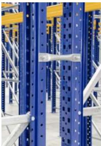
A – Kết nối back-to-back các dãy kệ để giảm độ mảnh và tăng độ vững chắc kết khối
