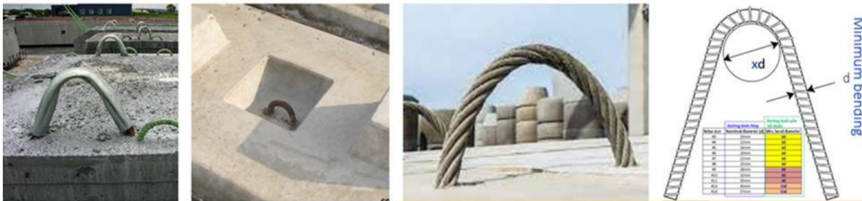
Tai móc cầu bằng cáp thép tránh được điểm uốn tại gốc Tai móc cầu bằng thép xây dựng không được uốn vuông mà phải uốn cong thỏa tỷ lệ xd/d
