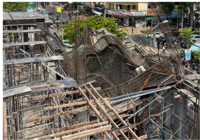
Kim Minh lắp giáo đơn khung H khi đổ bê-tông hồ bơi
