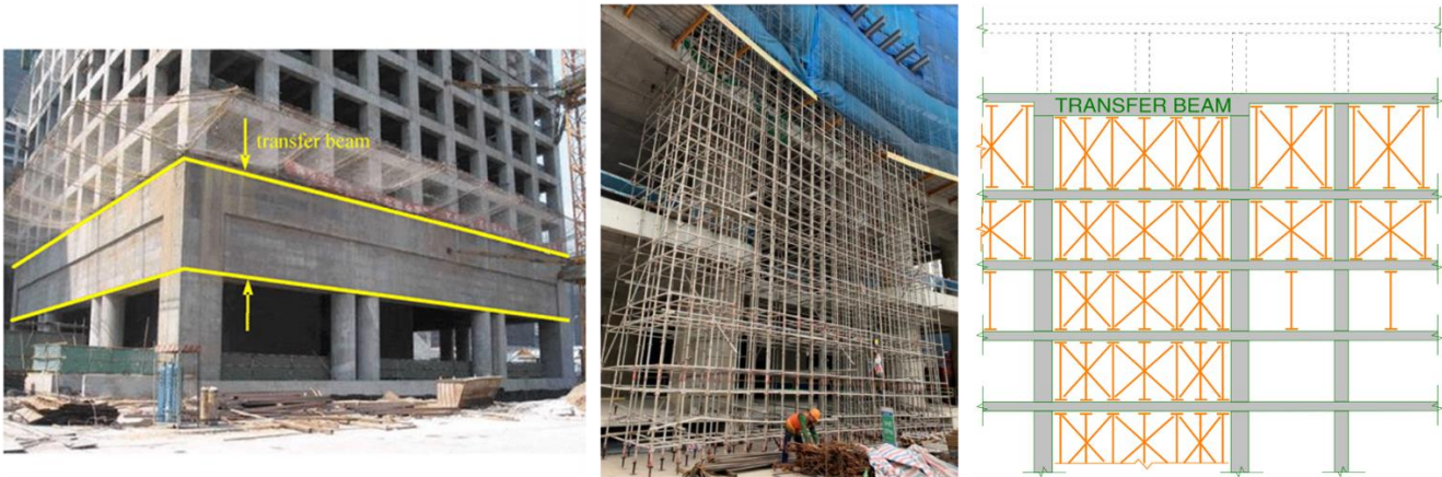
Hệ giáo chống dầm chuyển truyền thống ở một công trình nhà cao tầng
